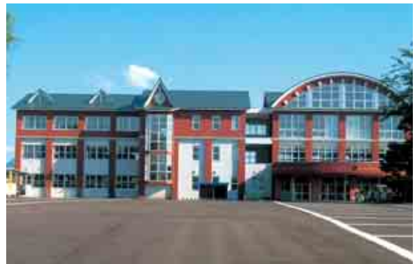
平成 18 年尾上中学校校舎完成。
