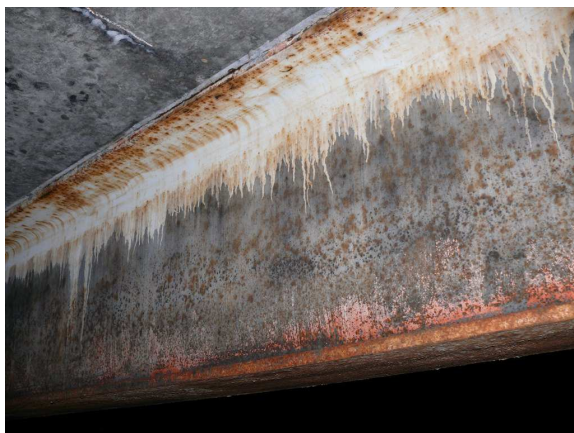
[御仮屋橋 主桁]
