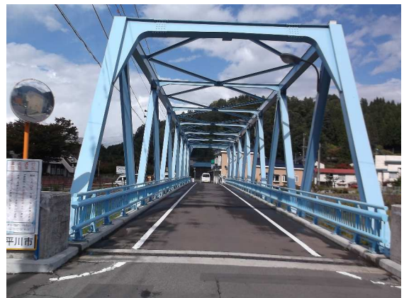
朝霧橋 2 巡目点検時 (H29) [塗装塗替え・伸縮装置取り替えほか]
