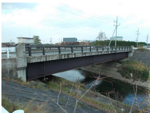
岩館猿賀線 北岡部橋
