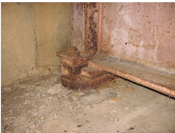
杉館橋 初回点検時 (H21)
