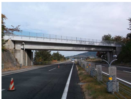
町居広船線 平賀三号橋
