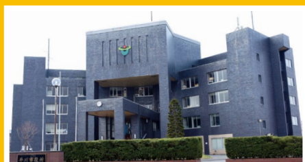
① 平川市役所本庁舎 (2階ロビー周辺)
