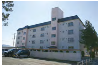
▶写真は2号棟です
